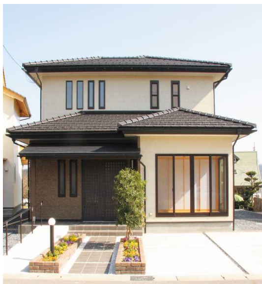
外観〔平成22年2月撮影〕
